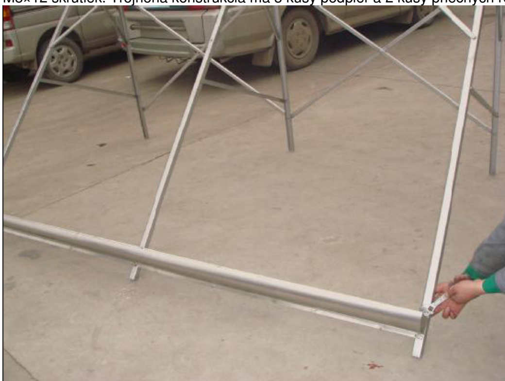
Obr. č.5: Spojiť dosadaciu plochu trubíc s prednou časťou nôh s párom skrutiek M8 x12.
