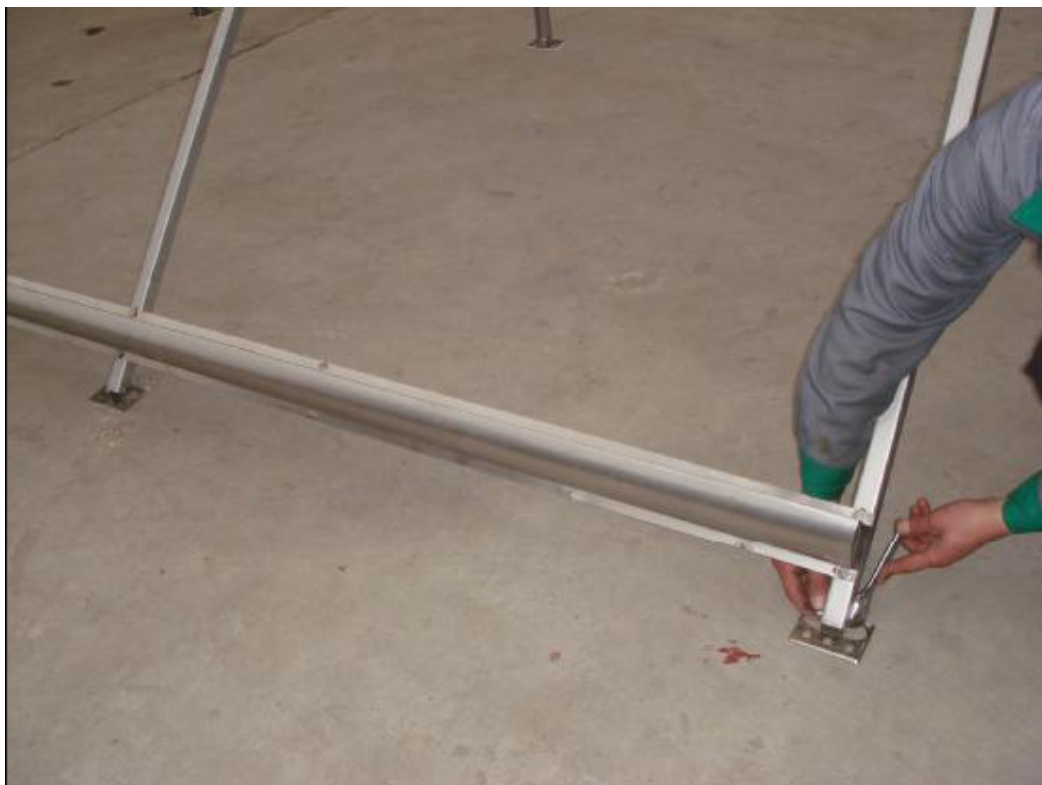
Obr.č.6: Pripojiť plechové pätky pomocou skrutiek pod predné a zadné nohy rámu.
