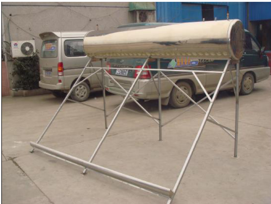
Obr. č.7: Po overení konečnej úpravy inštalácie konštrukcie, položte vodnú nádrž na rám a utiahnite skrutky.
