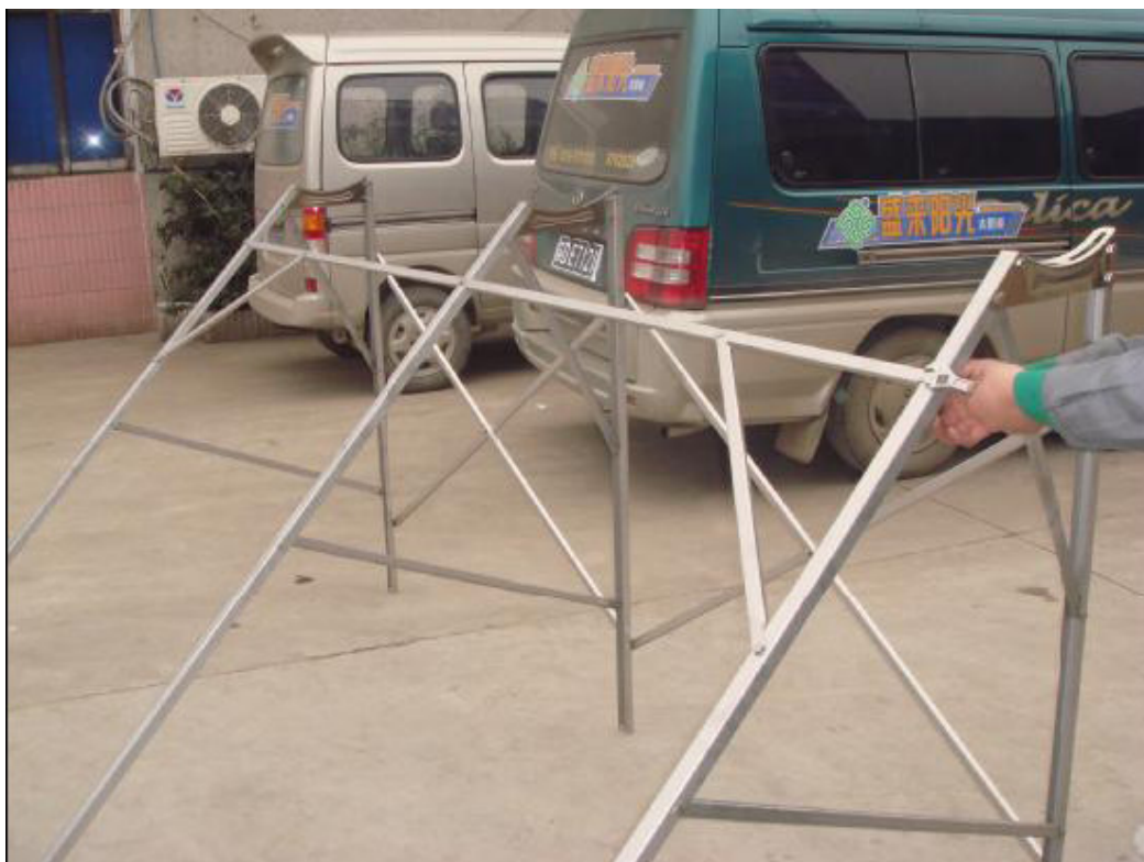
Obr. č.4: Pripojiť priečny nosník, pozostávajúceho z dvoch priamych tyčí s párom M8×12 skrutiek. Trojnohá konštrukcia má 3 kusy podpier a 2 kusy priečných rozpier.
